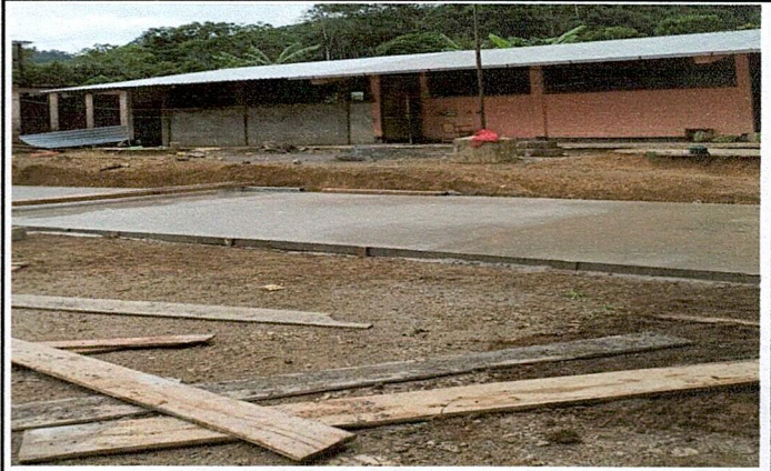
Foto 2: Mejoramiento de Patio
