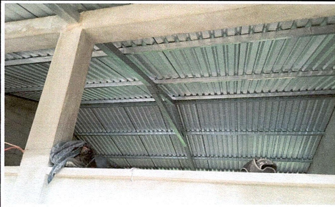
Foto 1: Ventanas parte frontal de aula Adicional
